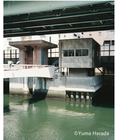
水門旧管理棟を再生したSUIMON HOTEL ©Yuma Harada
